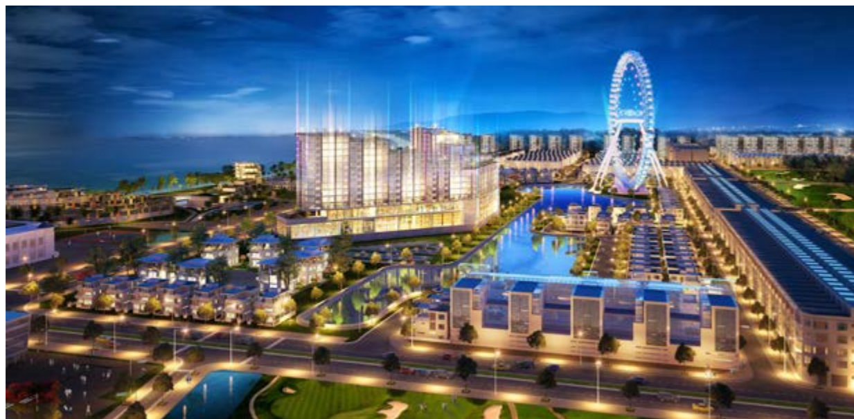
FLC Sầm Sơn Beach & Golf Resort (Giai đoạn 2): Dự án FLC Sầm Sơn giai đoạn 2 là dự án xây dựng khách sạn FLC Grand Hotel Sầm Sơn cao 15 tầng trên quy mô diện tích 35.958 m 2 bao gồm 3 tầng dịch vụ thương mại và 588 phòng khách sạn tiêu chuẩn 5 sao.
